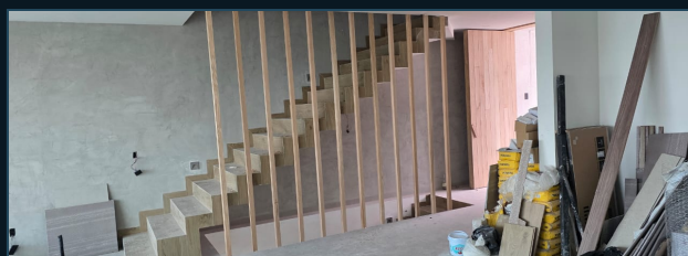
Barandal de listones de madera durante la instalación.
